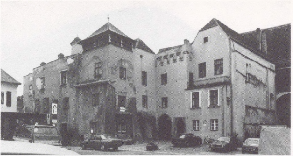
Abb. 2 Nordseite der Stadtbürg mit Torturm und Haupteingang vom Hohen Markt aus
