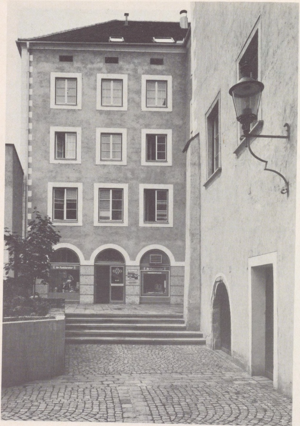
Abb. 12 Nach Umbau, Hof nach Westen
