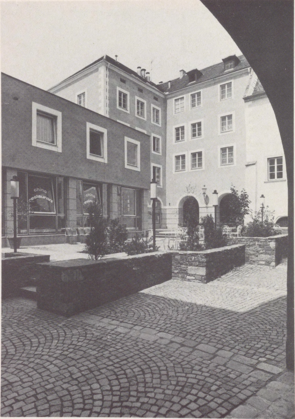
Abb. 10 Nach Umbau, Nordwestecke des Hofes
